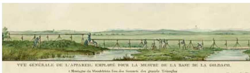
Vermessung der Basislinie zwischen Unterföhring und Aufkirchen, Aquarell von Daumiller, man sieht das Gerüst mit Stativbeinen zum Auflegen der Messlatten beim Überqueren des Flusses Goldach mit Blick auf den Wendelstein, Quelle: Bayerische Vermessungsverwaltung, München
